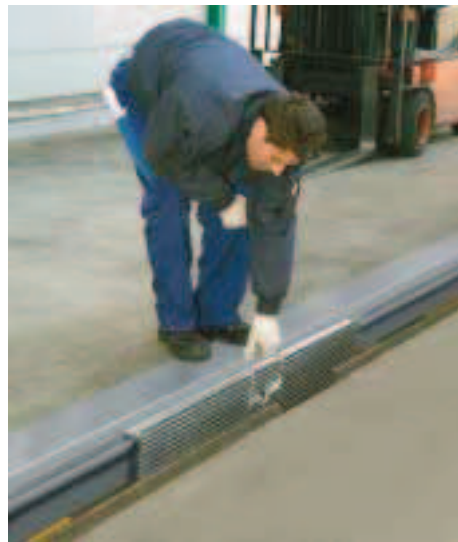
BB-Brücke aus der Führungsschiene herausheben.
